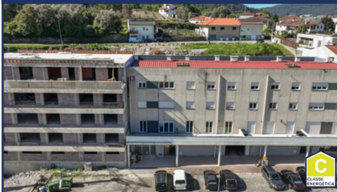
Fonte Arcada | Póvoa de Lanhoso
